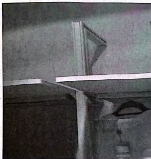
图 3-75 木层板与金属立柱的连接
